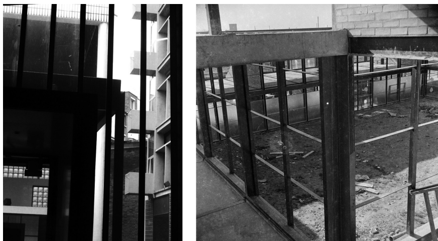
Figura 5. Comparación del autor entre las fotografías de la Ciudad Refugio en la actualidad y la escuela de Hunstanton durante su construcción
